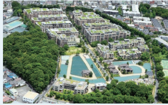
パークシティ大崎 ザタワー
