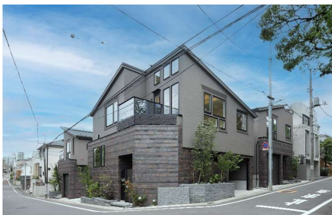
外観竣工写真（2 号棟）
