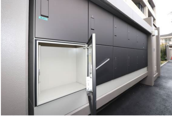
【マルチボックス施工事例】
