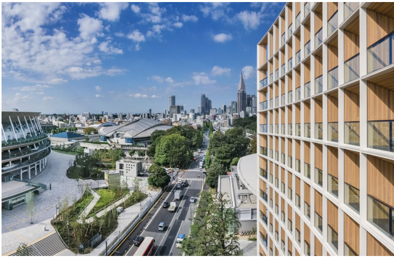
【SUSTIMBER 施工事例： 三井ガーデンホテル神宮外苑の杜プレミア】
