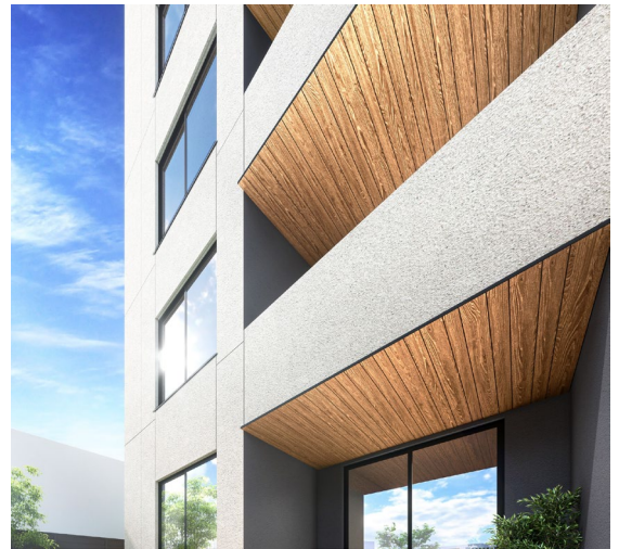
【SUSTIMBER を使ったバルコニー軒天】
