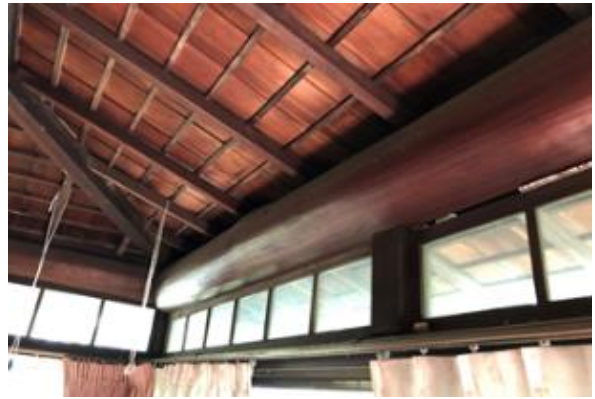
既存住宅内の「大梁」
