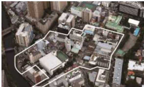
2011年撮影(既存建物解体前)
