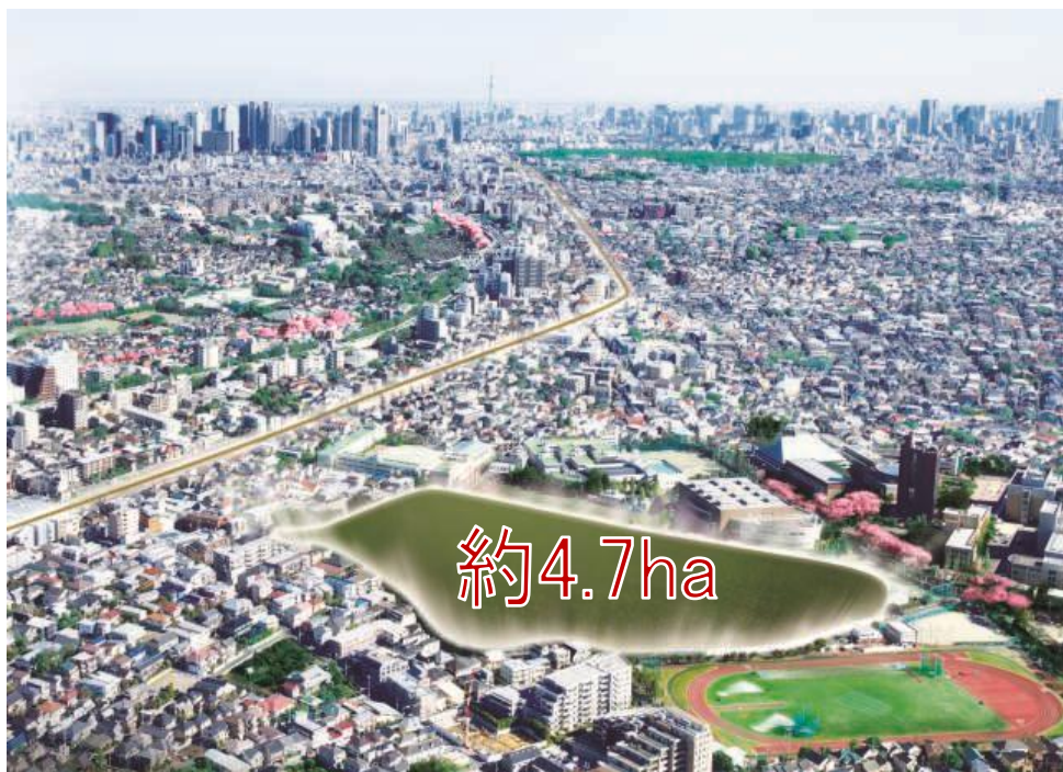
◀「桜上水ガーデンズ」建設現地 敷地空撮▶
