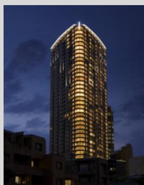
パークコート赤坂 ザタワー 総戸数:463戸 地上43階建 竣工年月:2009年6月
