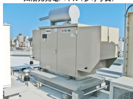
非常用発電機(参考写真)
