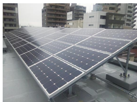
太陽光発電パネル(参考写真)
