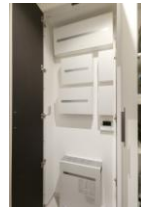
蓄電池・分電盤
