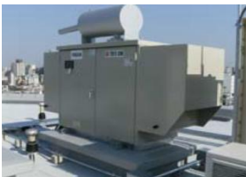
約72時間稼働可能な 非常用発電機
