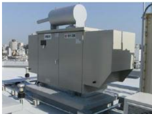
非常用発電機
