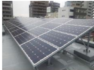
太陽光発電設備+蓄電池
