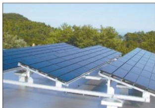
太陽光発電設備
