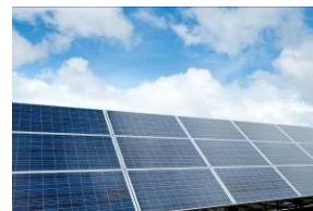
太陽光発電パネル（参考写真）
