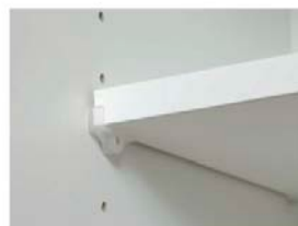
〈棚板脱落防止用ツメ写真〉
