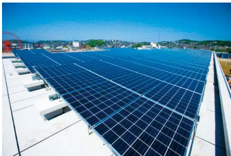
太陽光パネル（参考写真）
