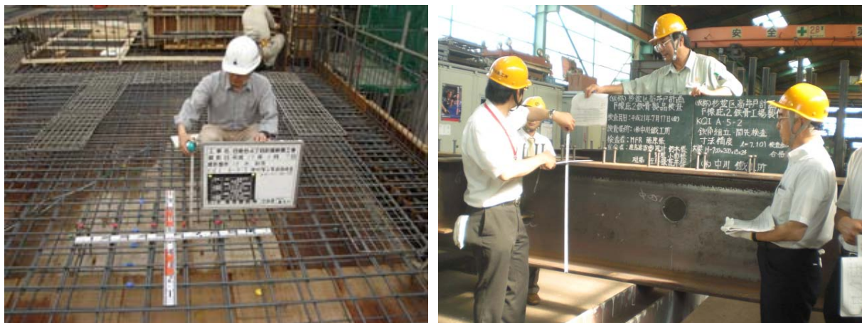
KQ I 現地立会検査風景
