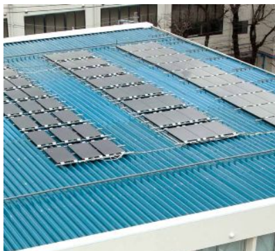
太陽光パネル
