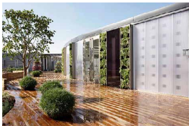
柏の葉フューチャービレッジ 外観
