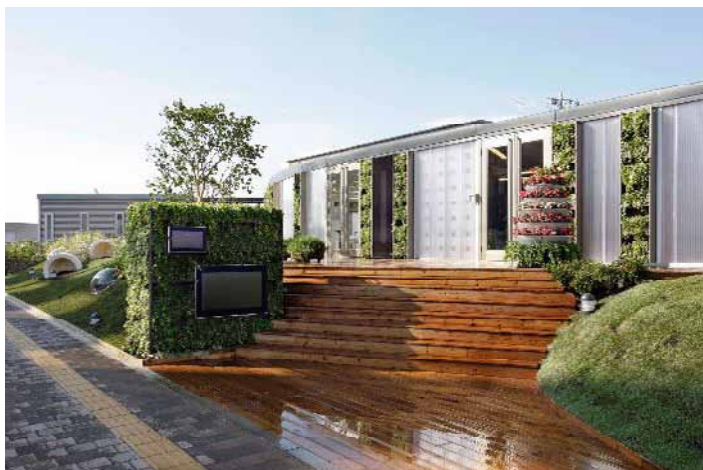
柏の葉フューチャービレッジ 外観
