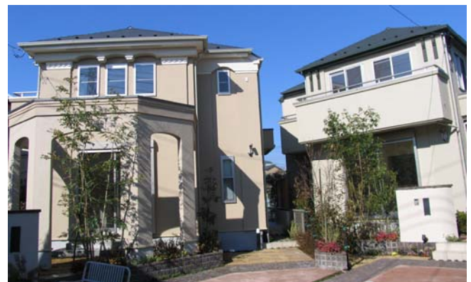
2・3 号棟外観写真
